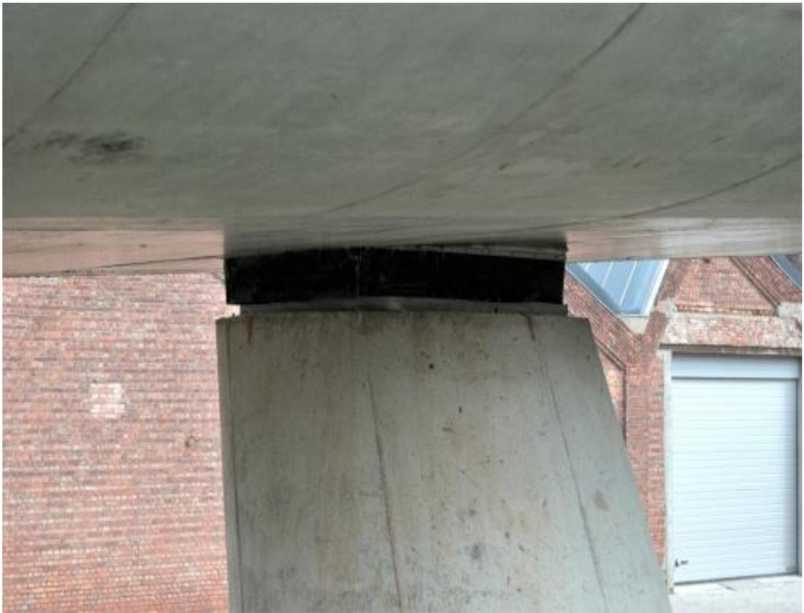
**Figure 5.1 : exemple d'un appareil d'appui. [9]**
