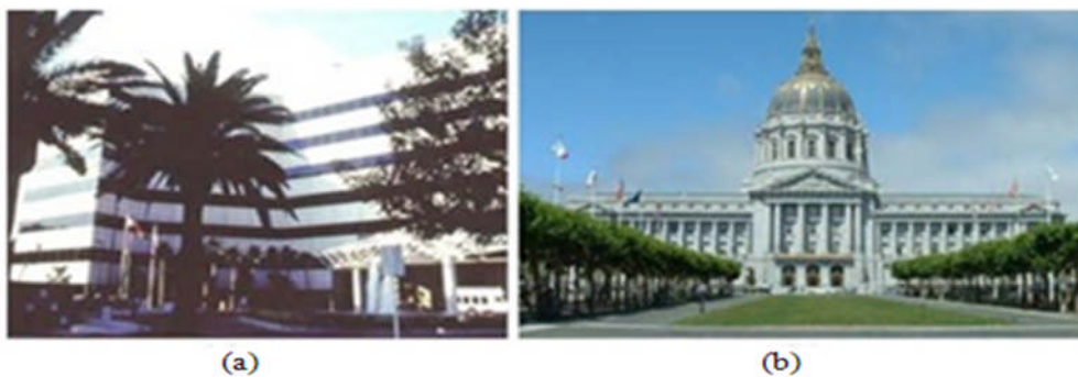
Figure I.13: Réhabilitation des structures à USA par des systèmes d'isolations
