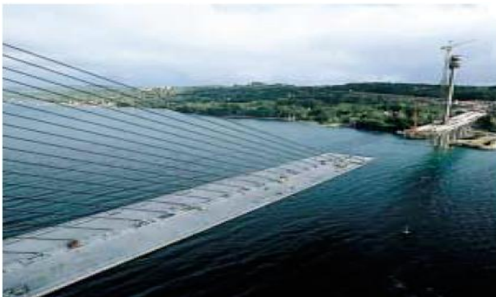
Figure 2. 1 Le pont sur l'Elorn
