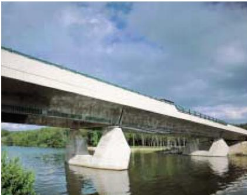
Figure 2. 2 Le pont de Joigny
