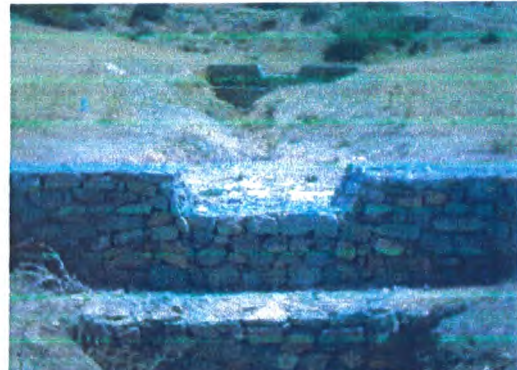
Photo 2 : Corrections torrentielles
