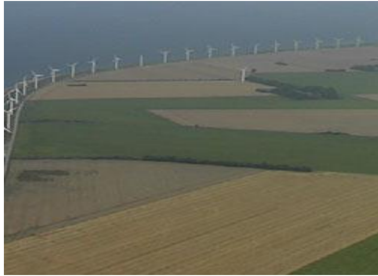
Figure I- 11: Insertion paysagère des éoliennes [11].
