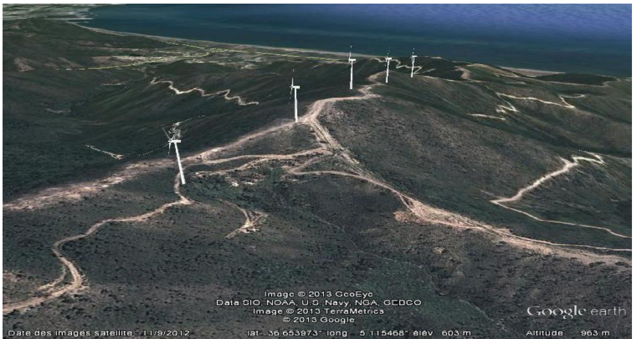
Figure III- 9: Parc éolien virtuel à Bejaia.
