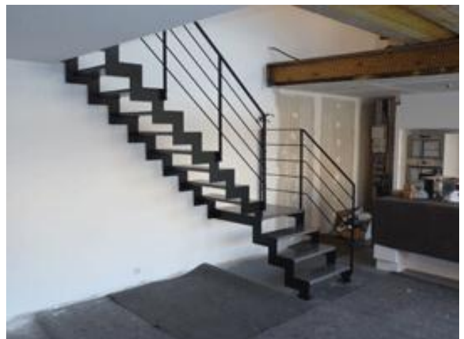
Figure V-1 Escalier en charpente métallique
