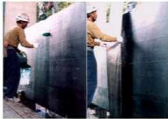
Figure III.3 : Procédé de réfection TFC.
