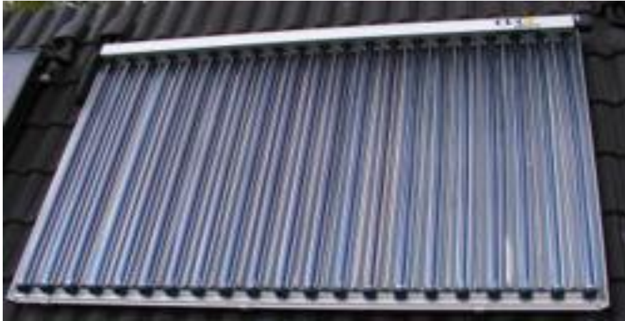
Figure [III-5] : capteur chauffe-eau solaire constitué de Tubes sous vide
