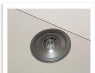
Figure 202: Illustration d'une bouche de soufflage
