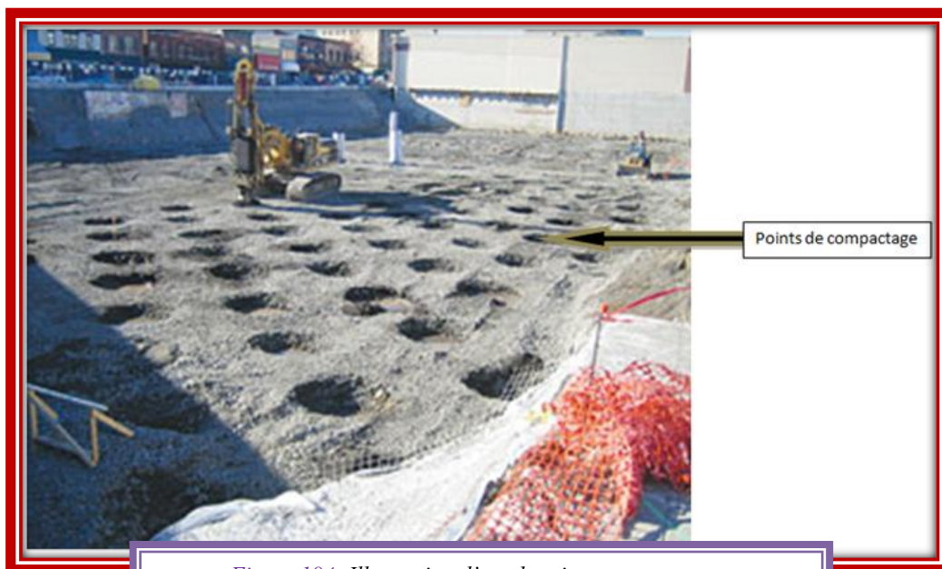
Figure 184: Illustration d'un chantier en compactage
