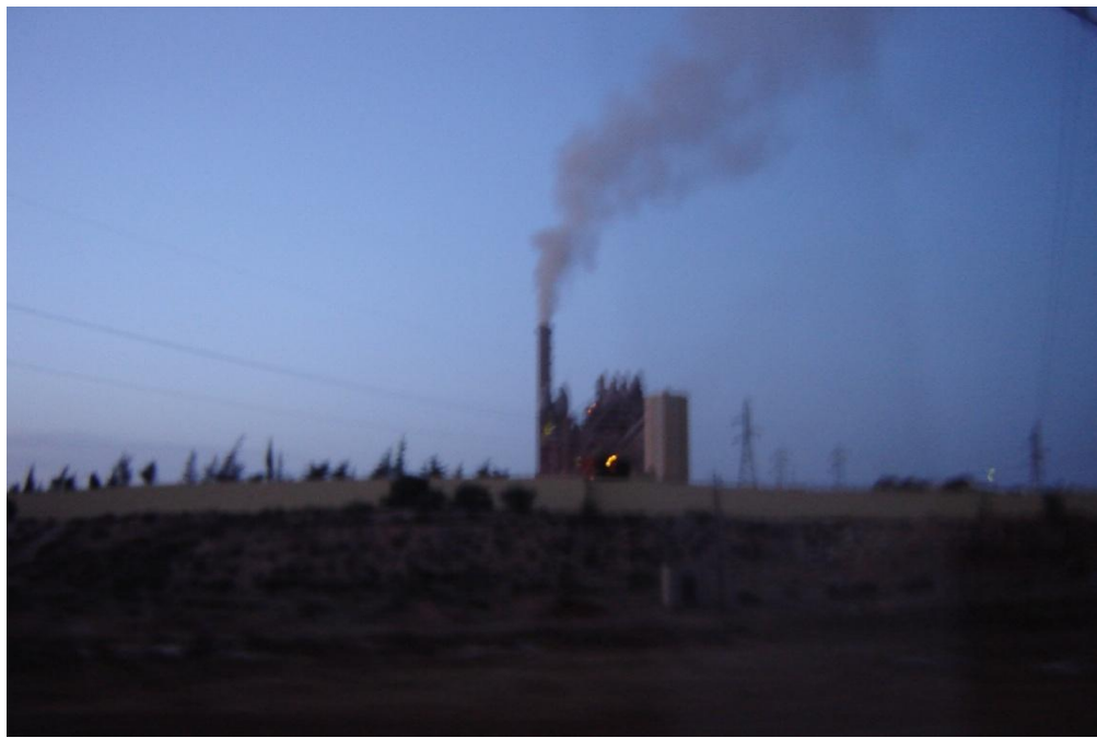
Figure II-2 : Cimenterie de Béni Saf
