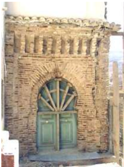
Figure 95: la porte nord-ouest décapée lors de l'opération de restauration. Source: CHIALI Abdessamed 1 .
