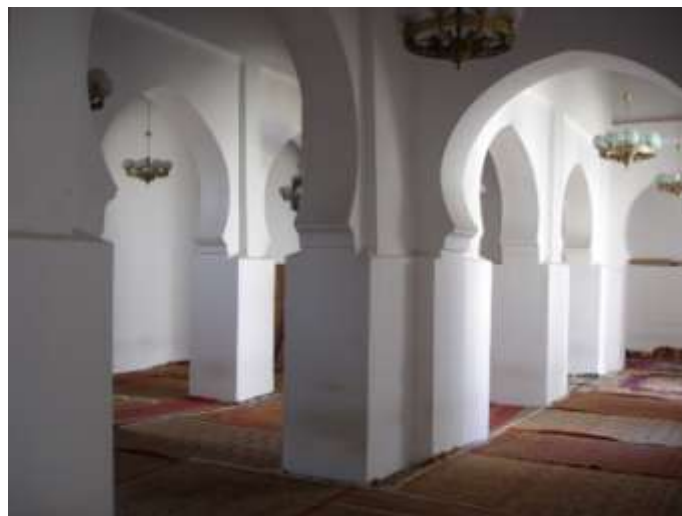
Figure 67: un pilier en forme de ( T ) dans la salle de prière.
