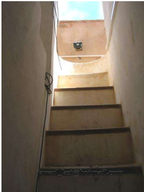
Figure 83: les marches et l'accès à la terrasse du minaret.
