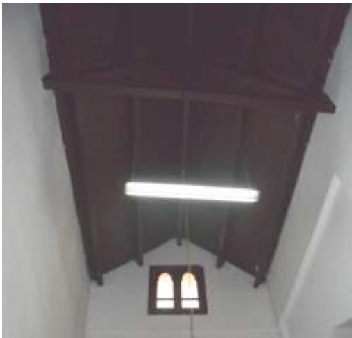
Figure 97: la charpente de la toiture en bois de Cèdre.
