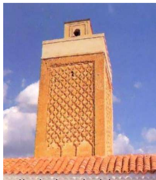
Figure 87: vue sur le minaret avant sa restauration. Source: Association El-Mouahidia.
