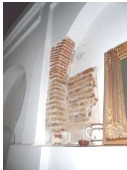
Figure 96: l'utilisation de la brique dans la construction des arcs à l'intérieur de la mosquée. Source : auteur.
