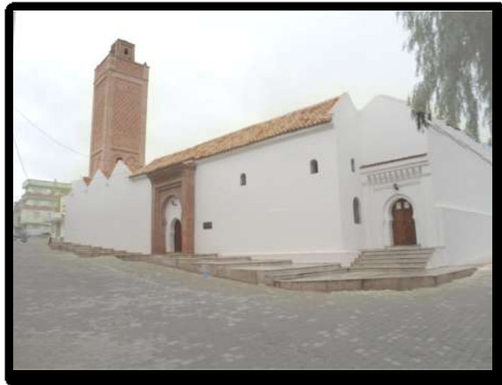
Figure 101: une vue générale sur la façade nord.
