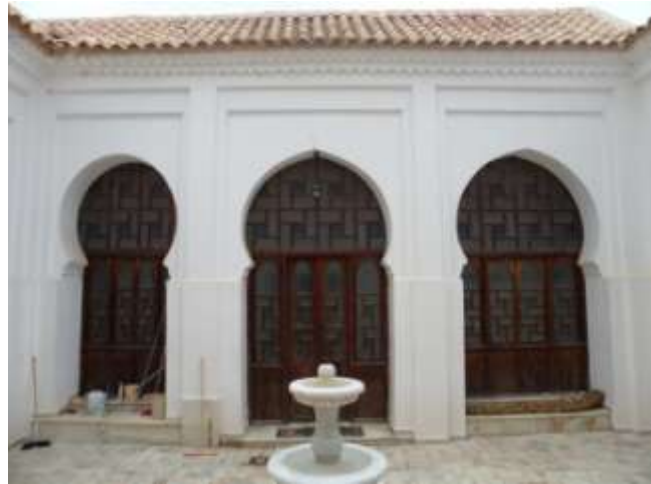
Figure 69: les arcs de la façade Nord de la cour. Source: auteur.
