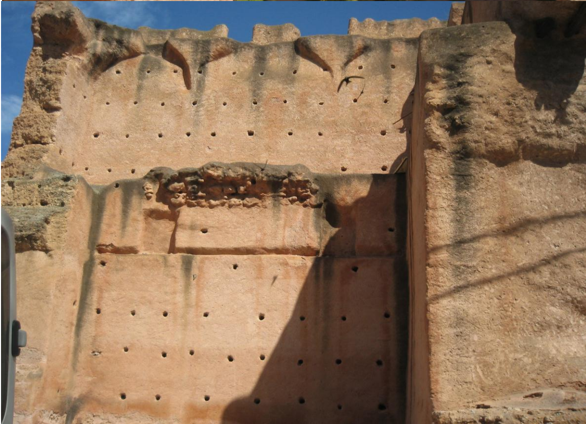
بقايا أسوار القصبة بندرومة 560
