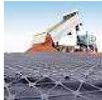
b. Géotextile tridimensionnel type Tensar
