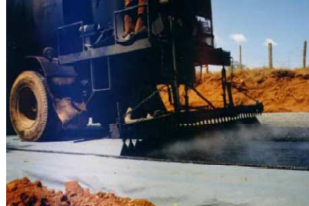
Géosynthétiques dans la construction d'une chaussée
