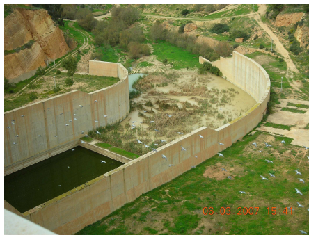
Photo 2.1. Stockage (a) et régalage (b) des sédiments de dragage
