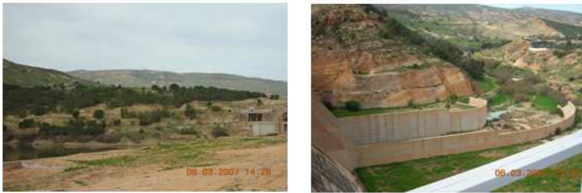
Photo 4.3. Vue d'ensemble du site du barrage Cheurfas
