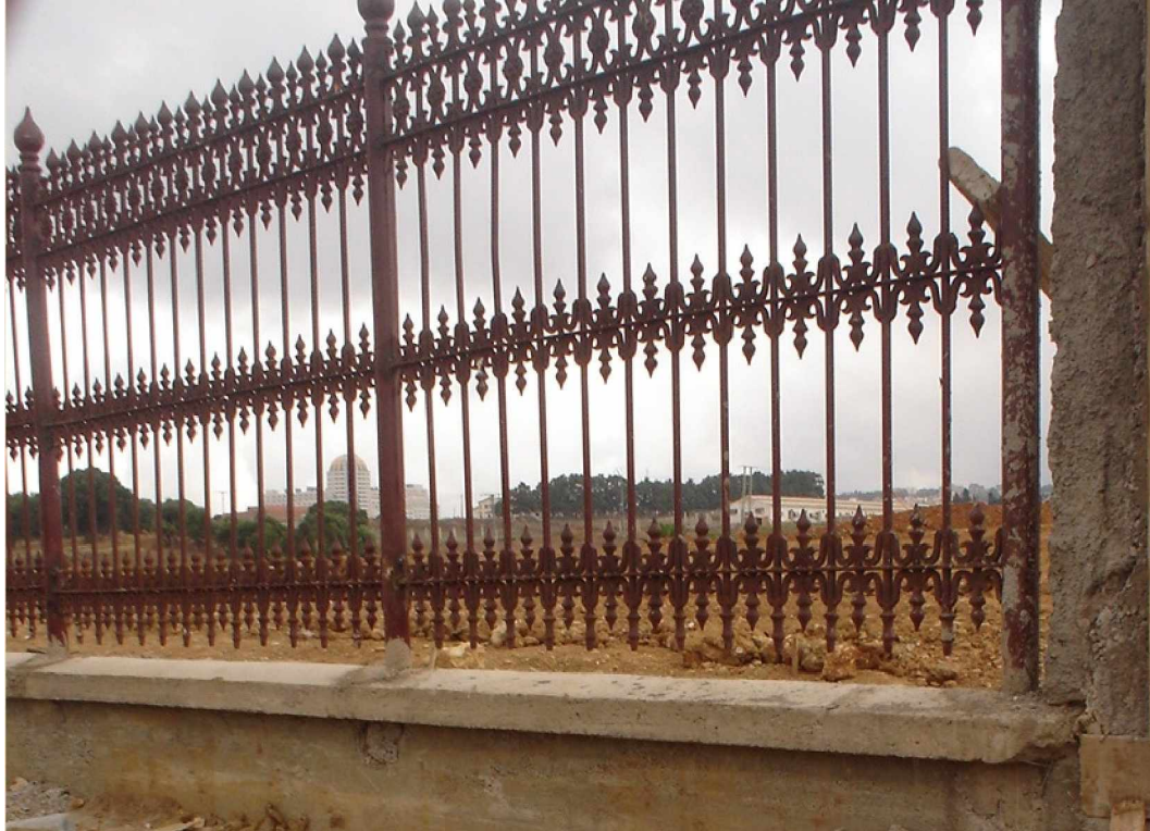
Photo 17 : Clôture du parc [Dossier Technique]
