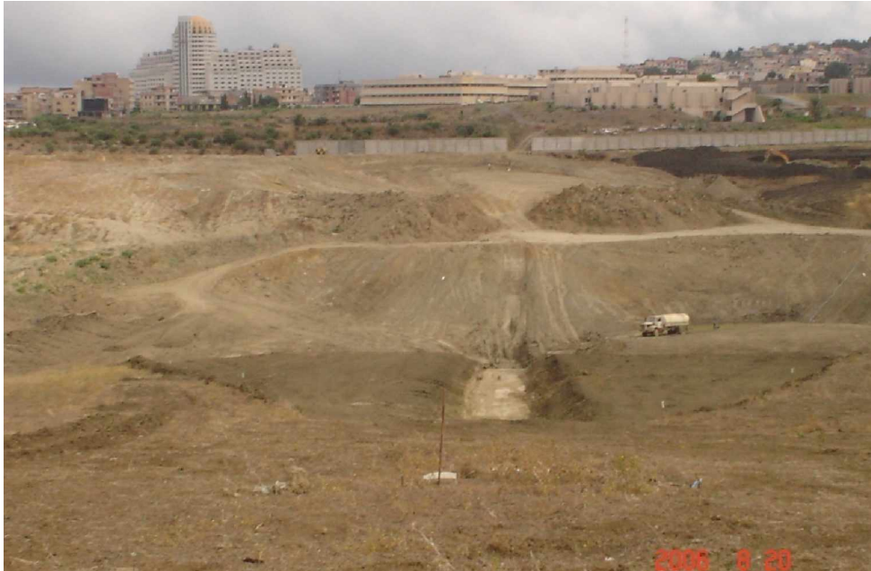
Photo 18 : Retenues collinaires en construction
