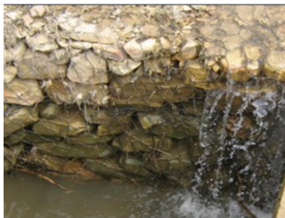
Photo (1.4) : Seuils de sédimentation en Gabions et en pierres sèches réalisés dans le bassin Versant du barrage BAKHADDA
