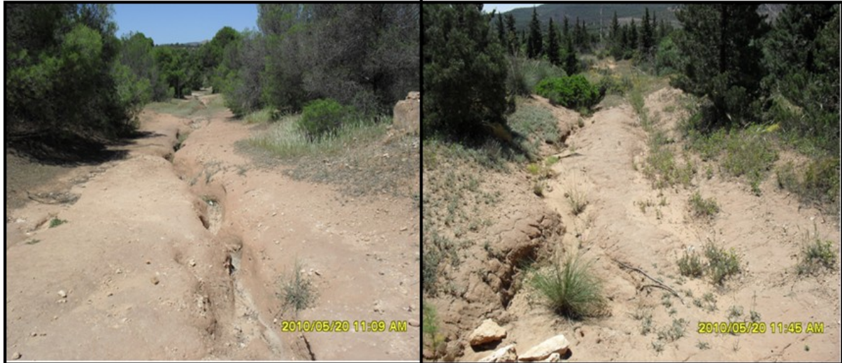
Figure 45 : Layon sur pente faible endommagé par l'érosion (à gauche).
