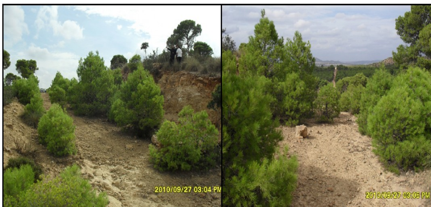
Figure 35 : Plateforme routière coupé par une recolonisation de pin (à gauche).
