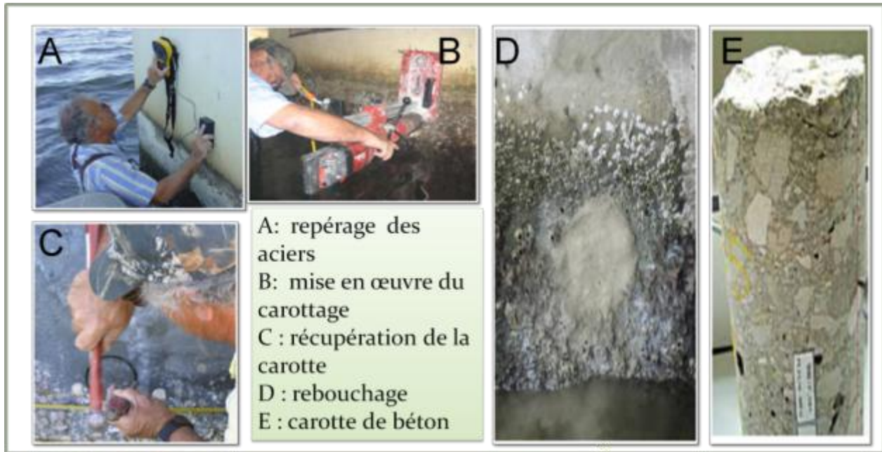
Figure II.29 : Différentes étapes d'élaboration d'un carottage [VIRA, 07].
