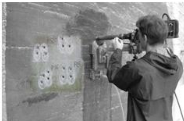
Figure II.28 Exemple de prélèvement des échantillons de poussières à partir d'une structure en béton [AFGC, 03].
