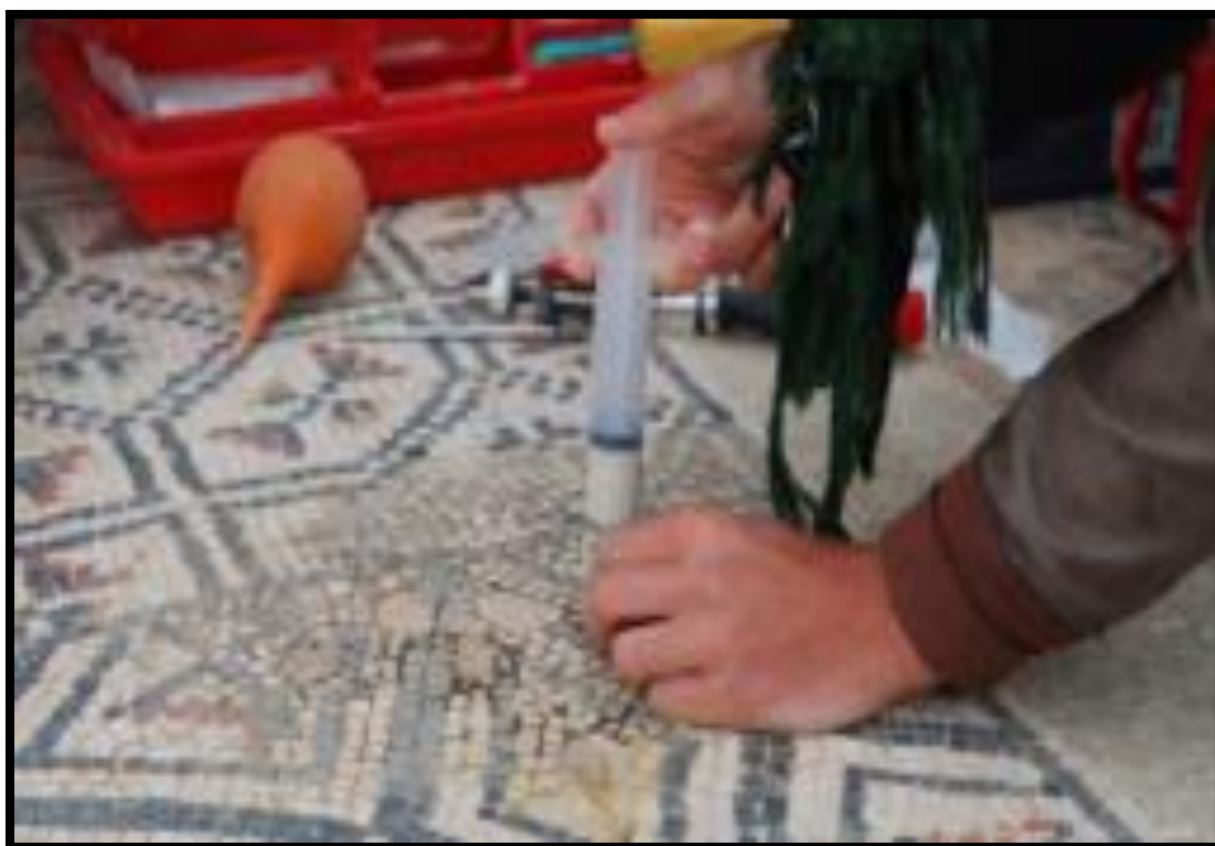
الصورة رقم ( 51 ): عمليات ملأ الملاط بين طبقات الفسيفساء
