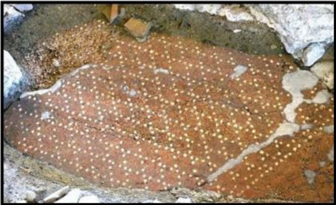
الصورة رقم ( 12): تقنية سغنينوم opus signinum
