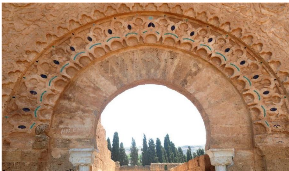
الصورة رقم 07: تبين العقد الذي يعلو المدخل
