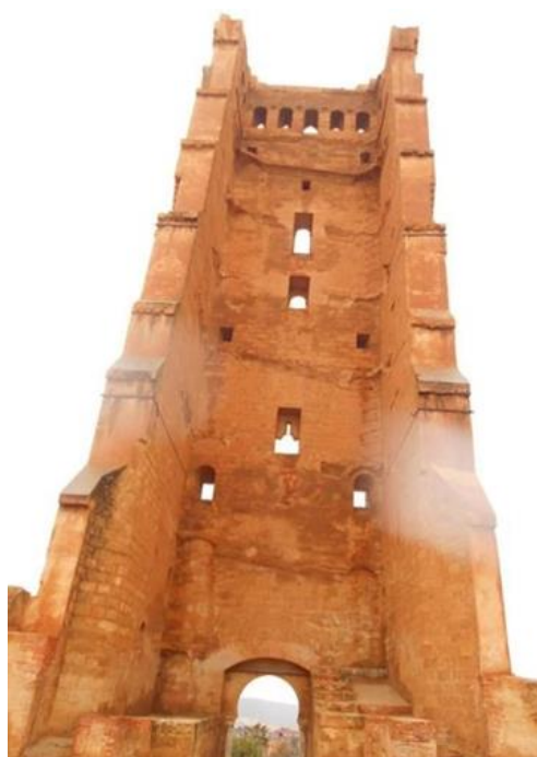
الصورة رقم 03: تبين النواة المجوفة للمنذنة
