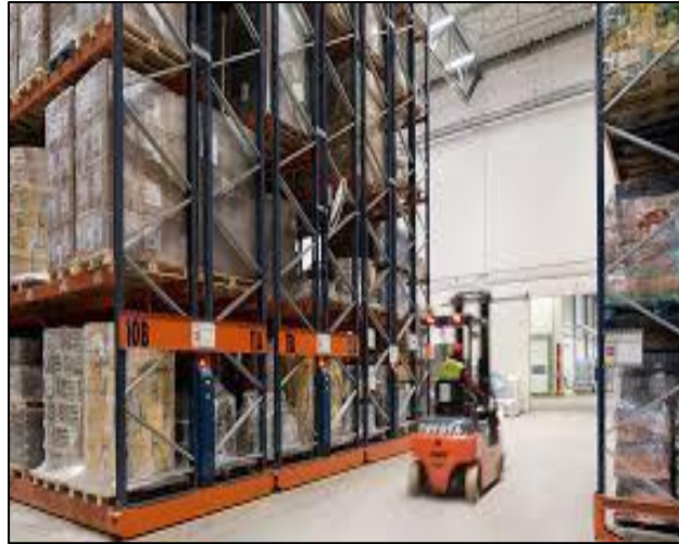
Figure n°06 : Ligne de stockage (Site N° 10)
