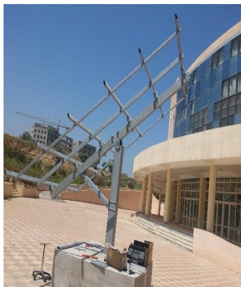
Figure 3.33 – Suite et fin du montage de la structure métallique
