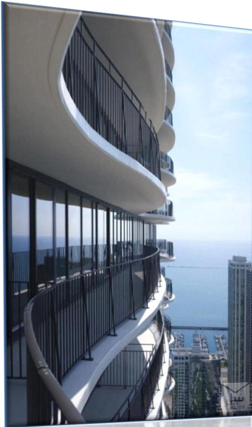
'الشكل (89) طوابق برج أكوا
