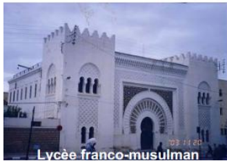
Photo 63: ilot-équipements civils (Lycée France musulman) 47
