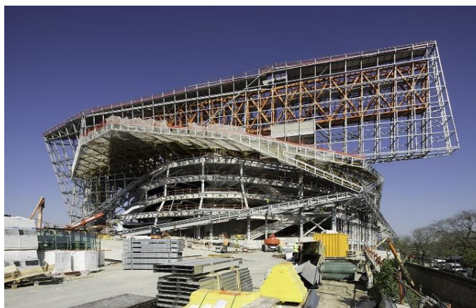
Figure 37: la structure de la philharmonie de paris
