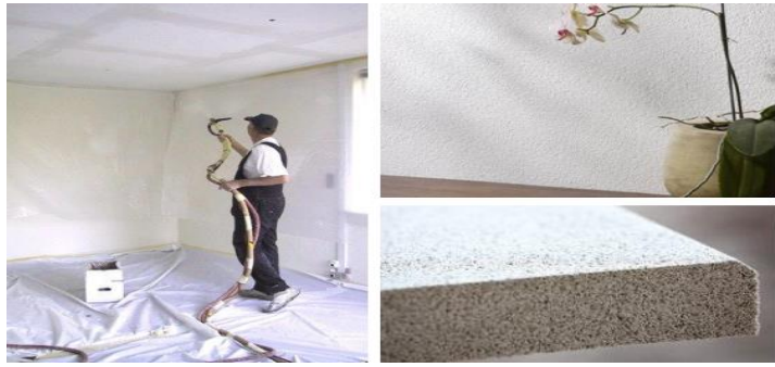
Figure 63: enduits absorbants
