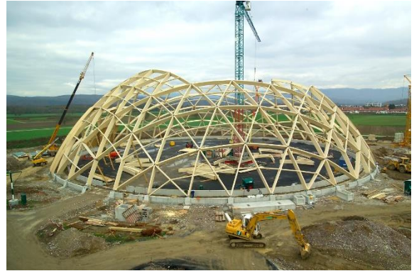
Figure 18: construction tridimensionnelle en bois
