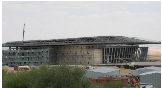
Figure 19: zenith de Constantine en structure tridimensionnelle
