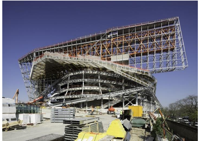
Figure 8:structure métallique dans la philharmonie de paris
