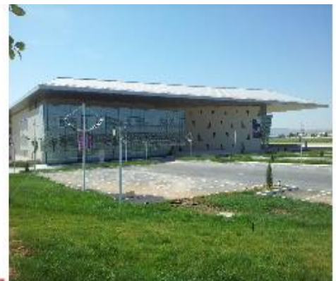
Vue sur la façade ouest
