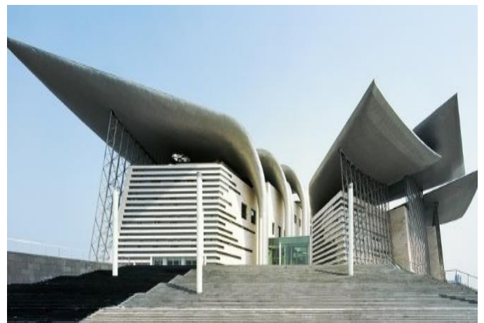
Figure 9:Le Grand Théâtre de Wuxi construit en treillis spatial
