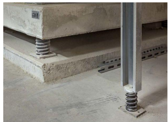
Figure 57: système d'isolées du sol par des boîtes à ressorts
