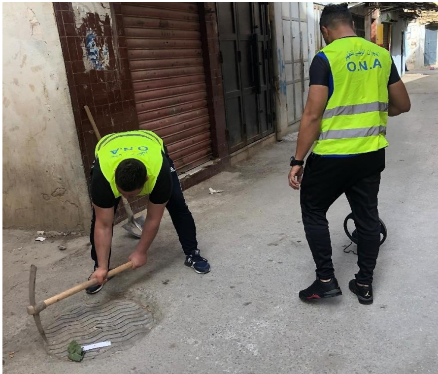
Figure III.6 : Ouverture de tampon de regards en sécurité (Derb Sidi Hamed).
