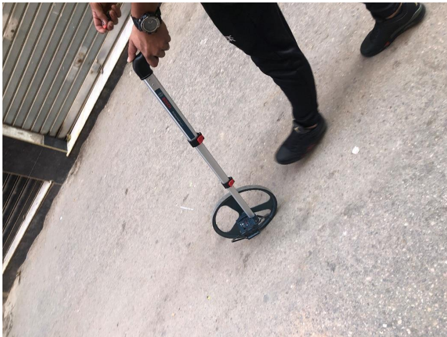
Figure III.5 : Mesure de la distance entre deux regards. (Rue Ibn Khaldoun).
