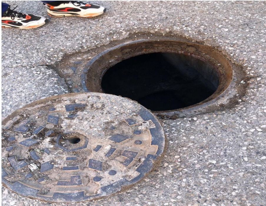
Figure III.4 : Type de couverture d'un regard.
