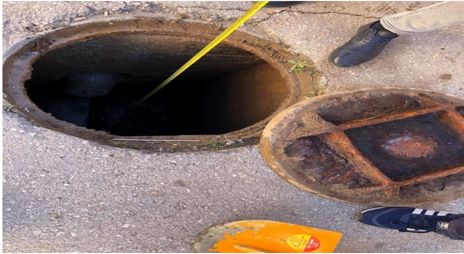
Figure III. 2 : Mesure de la profondeur d'un regard. (Quartier de Hartoun).
