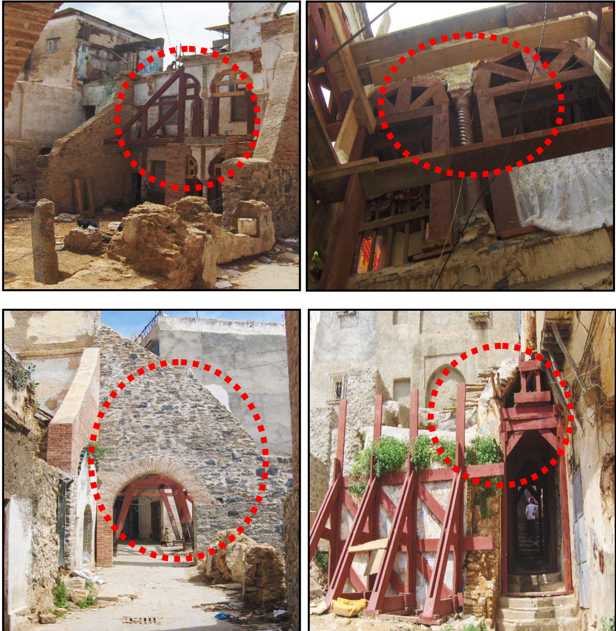
Photo. 30: Travaux d'étalement intérieur et extérieur des maisons menaçants ruines. Source : CNERU 2007.
