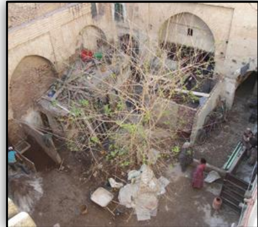
pendant les travaux
