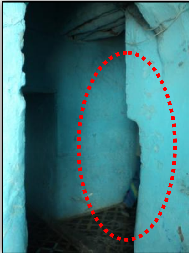
Photo. 75: Ornementations et traitement d'angle, Dar El Baroudi . Source : Auteur.
