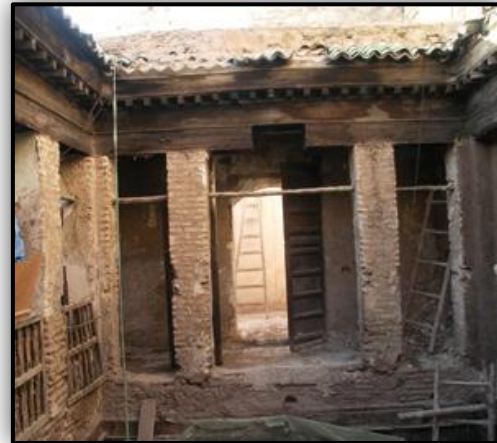
pendant les travaux
