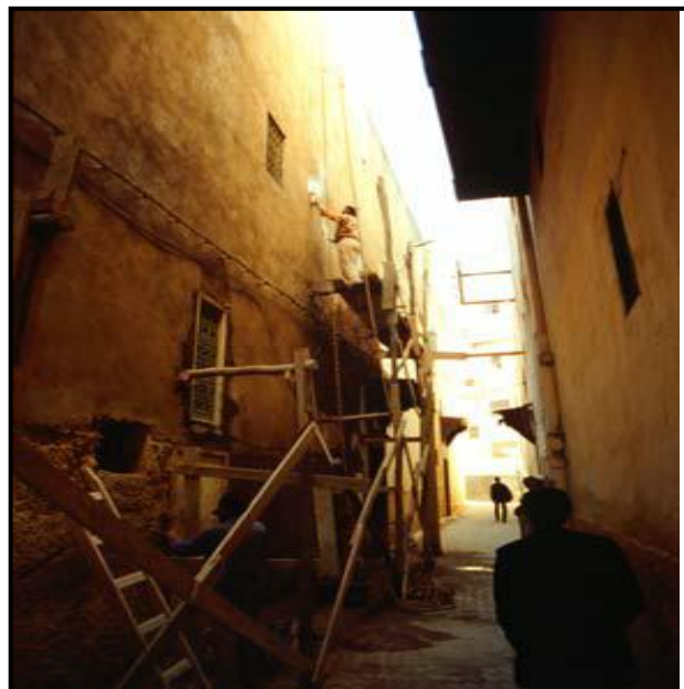
Photo. 12: Travaux de ravalement de façade d'une vieille maison - Fès.
