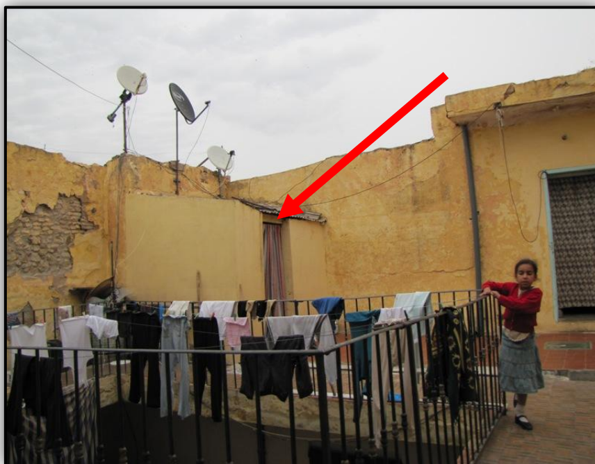
Photo. 51: Partie rajoutées récemment au niveau de la terrasse « Stah ». Source : Auteur.
