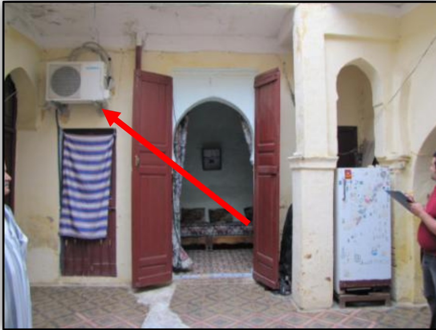
Photo. 52: L'installation d'un climatiseur sur le mur d' El Ghorfa . Source : Auteur.
