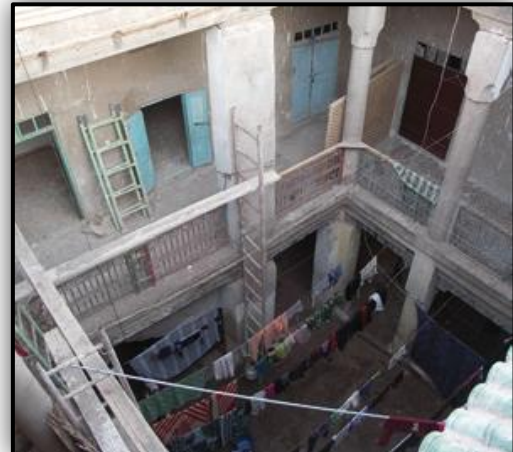
pendant les travaux
