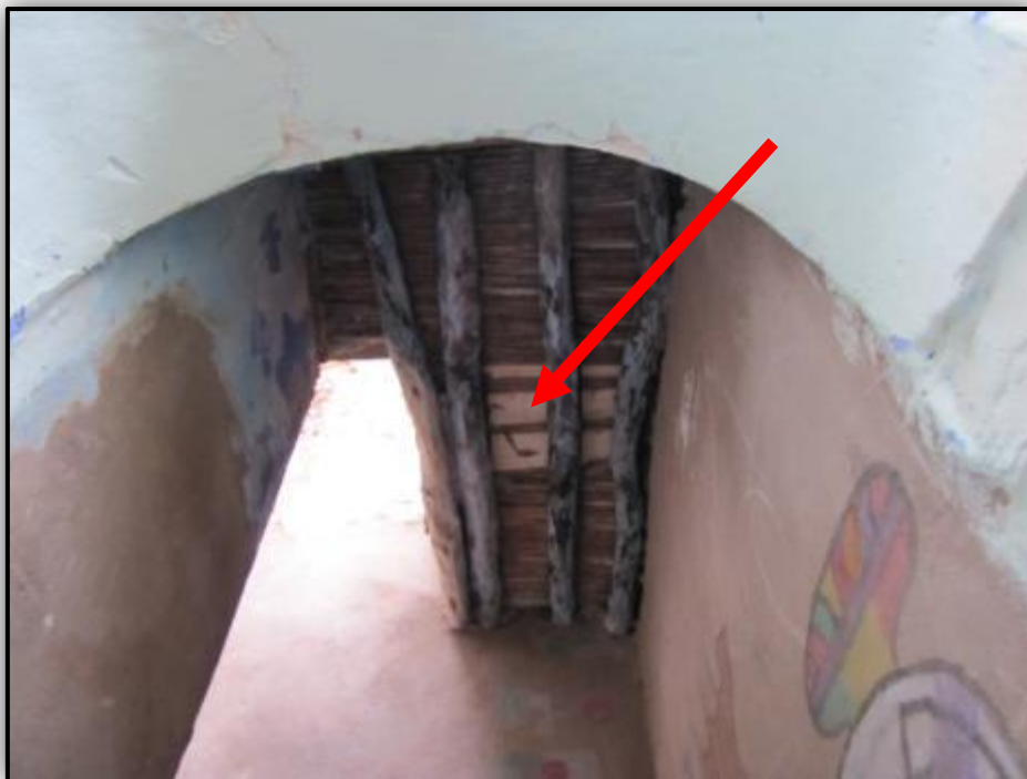
Photo. 64: Les planchers en rondins de bois, Dar Tchouar .
