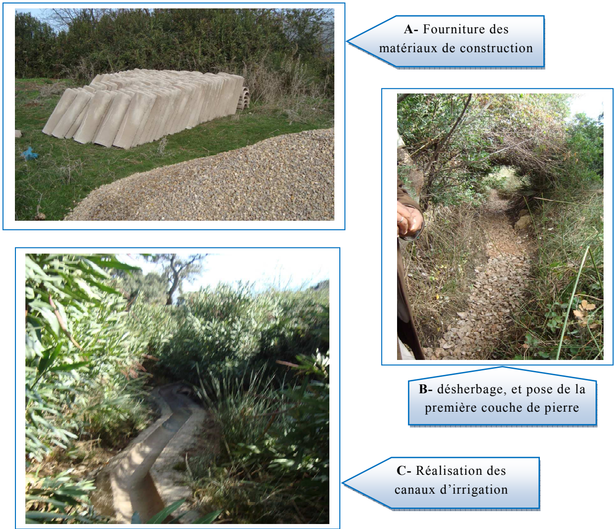
Figure n° 43 : Quelques photos de travaux de réalisation des canaux d'irrigation) (P.N.T., 2012)
