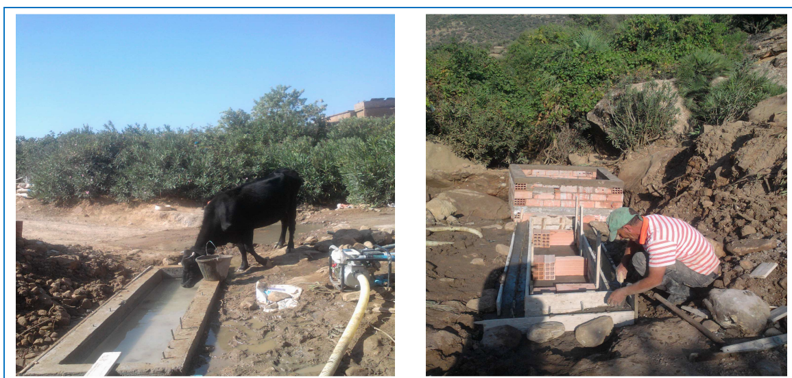
Figure n° 44 : Quelques photos de travaux de captage de source (P.N.T., 2012)
