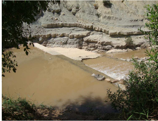
Figure n°30: Déviation de l'eau de Oued Tafna par le 'Sad'
