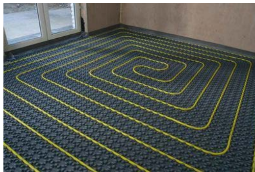
Figure II. 26. Schéma d'un plancher chauffant. [44]
