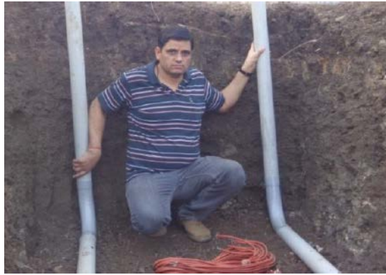
Figure I. 20 : Image réelle de l'installation de l'échangeur.
