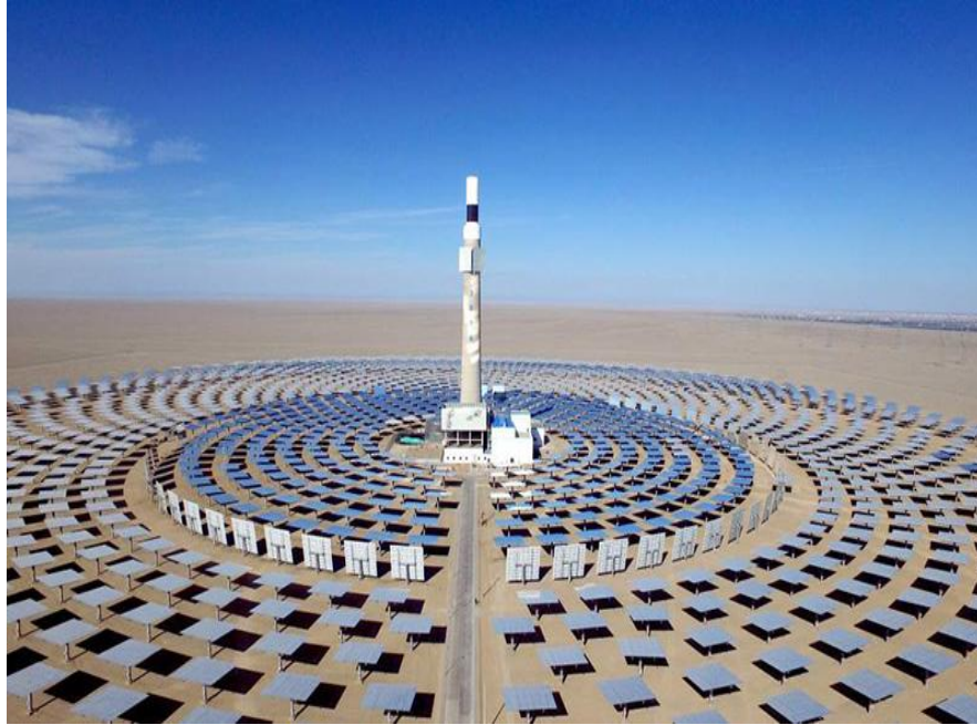
Figure I.20 : Centrale solaire thermique de Souan Dunhuang dans le désert de Gansu (Chine) [20].
