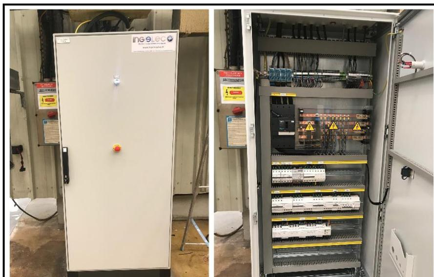
Figure I.10 : Armoire pour éclairage de remplacement [9].
