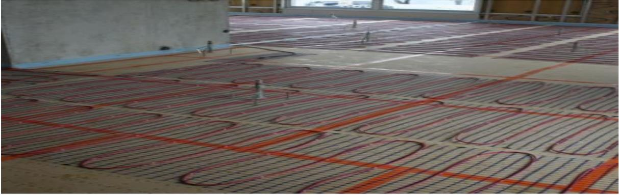
**Figure (2.15) :** Exemple de Plancher chauffant électrique
