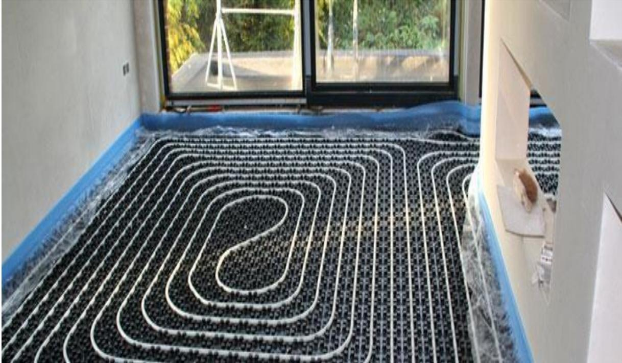
**Figure (2.5) :** réseau de tubes d'un plancher chauffant hydraulique [14]
