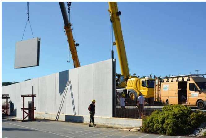
Figure 17 : Image montage de panneaux préfabriqués sur chantier
