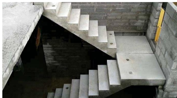
Figure 64 : Les cages d'escaliers préfabriqués
