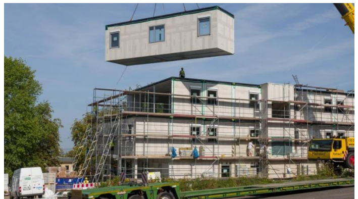
Figure 2 Installation d'un module complet. (hors-site s.d.) https://www.saebu.fr/construction-modulaire/construction
