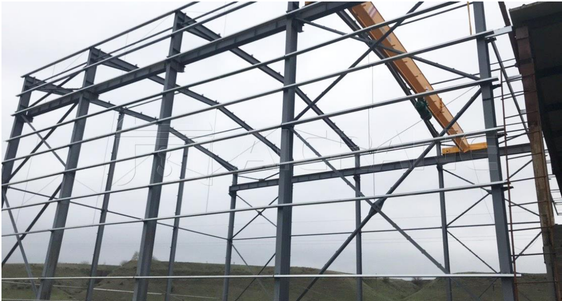
Figure 8 un type de contreventement préfabriqué. (construiracier s.d.)
