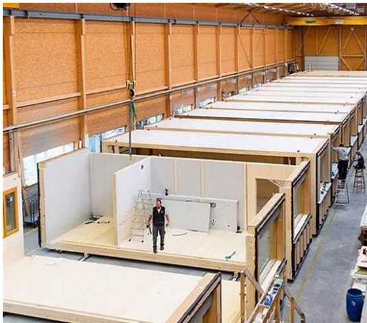
Figure 12 usine préfabrication de module
