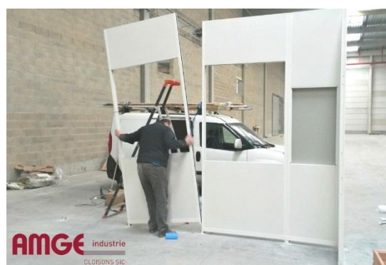
Figure 11 cloison préfabriquée. (abc construction)
