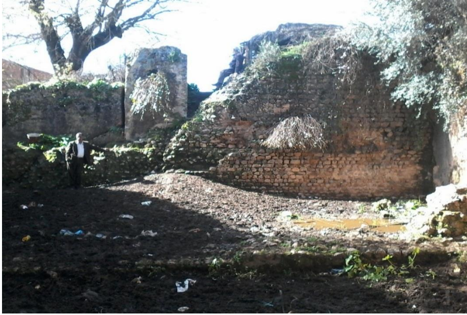
الصورة رقم 20: منظر للجدار الجنوبي للجزان
