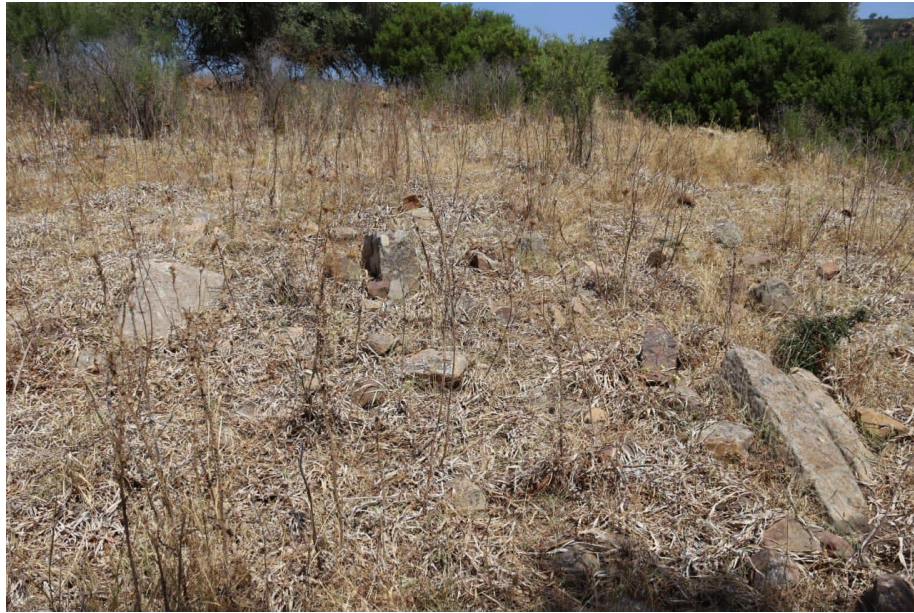
الصورة رقم 75: بقايا أساسات بناية خارج ملكية رقامي
