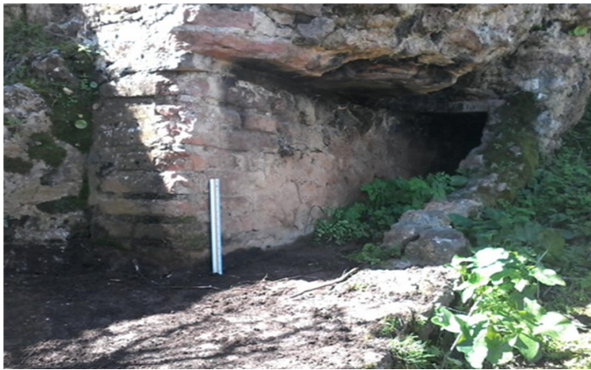
الصورة رقم 24: قناة المياه
