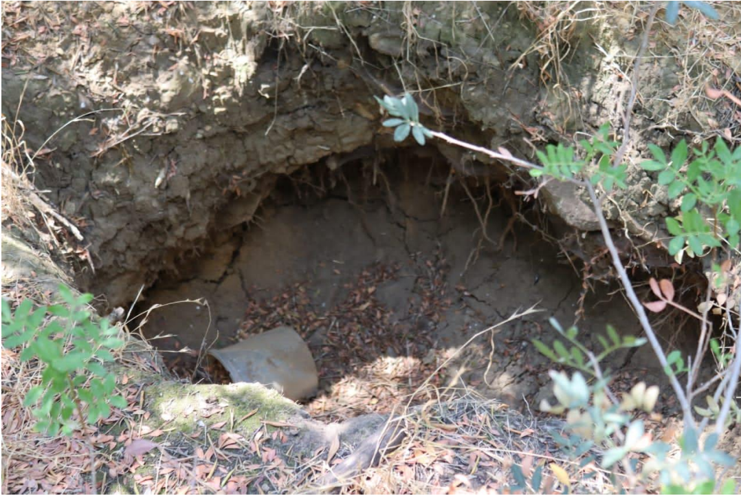
الصورة رقم 58: أعمال التخريب التي طالت الموقع
