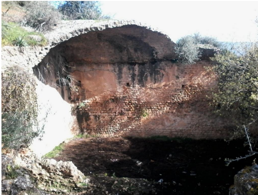
الصورة رقم 19: منظر للخزان من الداخل والسقف
