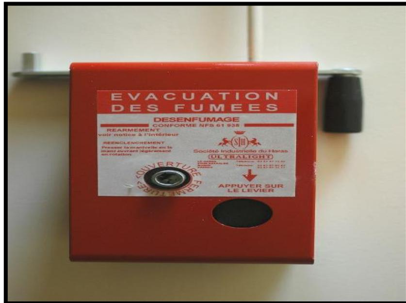
Figure 8 : boîtier pour mise en œuvre du désenfumage (INRS, 2022).
