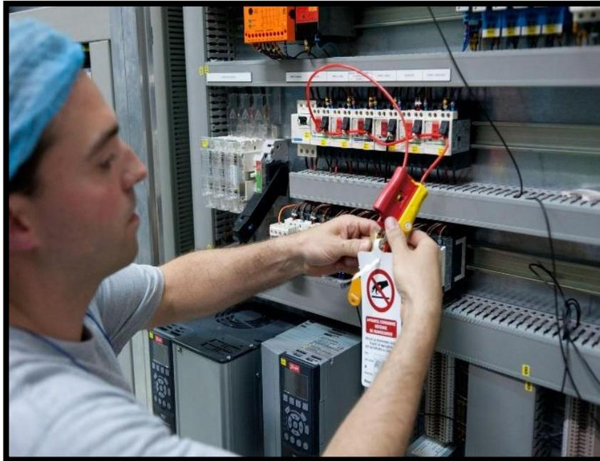
**Figure 9 : consignation dans un local technique pour intervention de maintenance électrique (INRS, 2022).**
