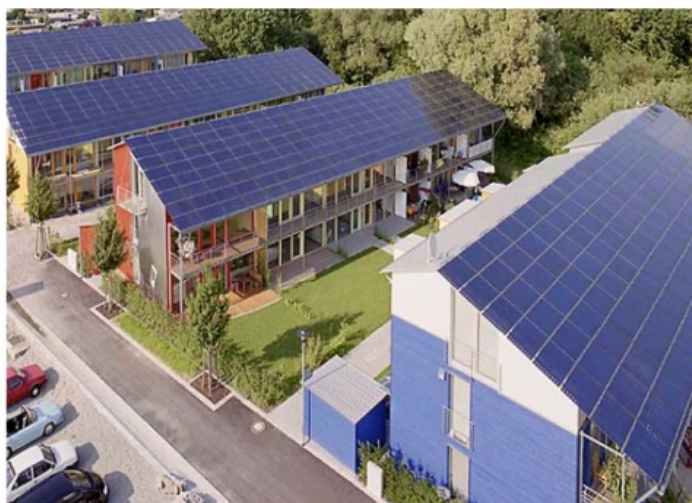
Figure 12 : Vue de la cité solaire du Schlierberg ( Freiburg ,Allemagne) [ Schlierberg 2007]
