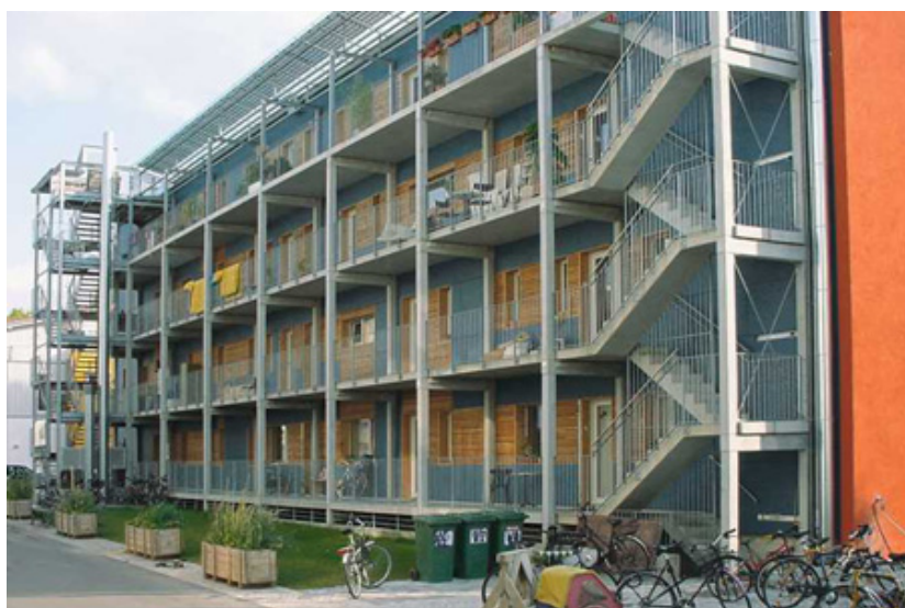
Figure 10 : Vue du bâtiment Wohnen & Arbeiten (Freiburg, Allemagne) [ solaires-bauen]
