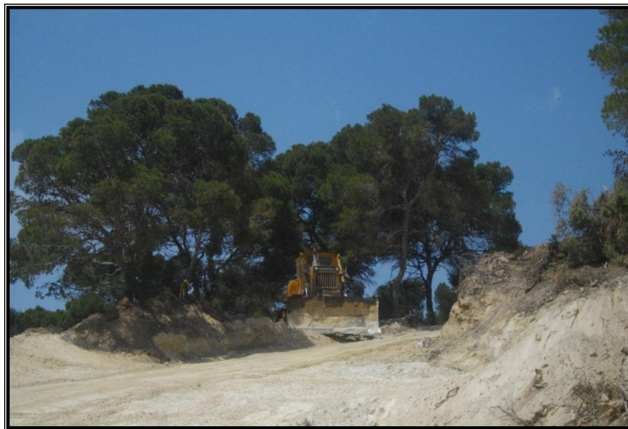
Photo 3: Travaux de station dessalement d'eau de mer (disparition d'une partie de la forêt Ouled Youcef : le 04/01/2011).
