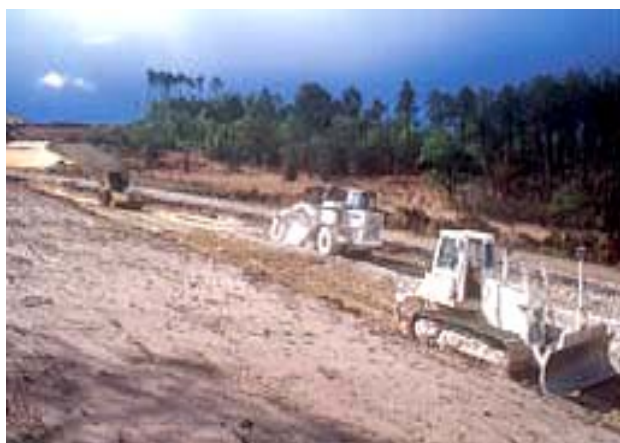
Figure VI.19 – Vue générale d'un chantier de traitement de sol.
