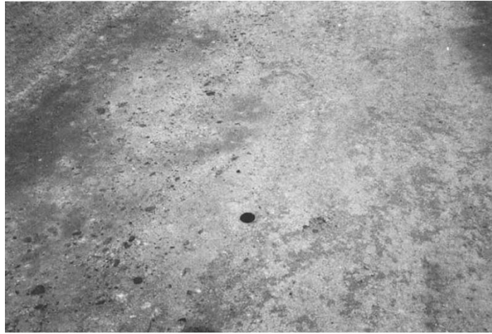
Figure I.30 – Accotement réalisé à partir d'un mélange contenant 50% de tuf et 50% de grave 0/50 (Colombier, 1988).
