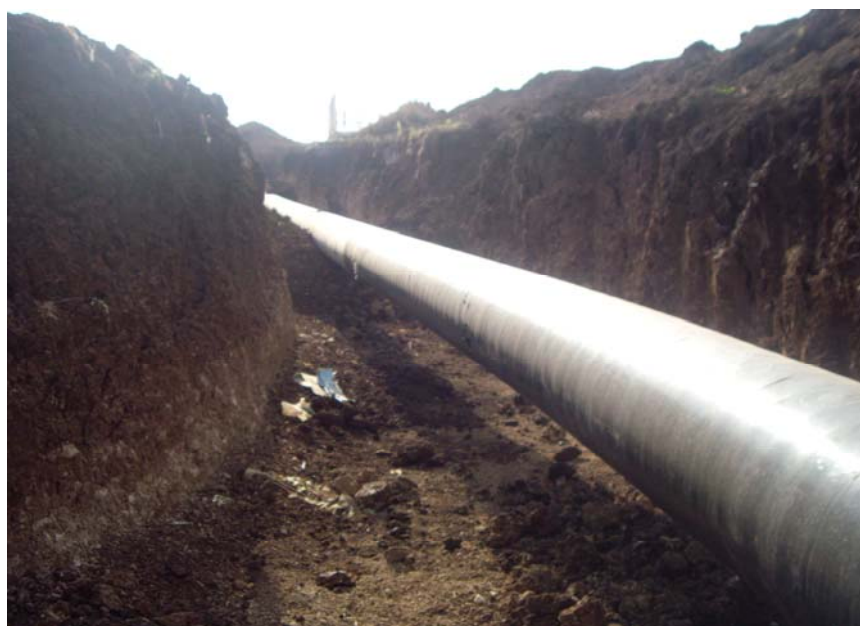
Figure 3.13 : Pipeline en phase d'enterrement.
