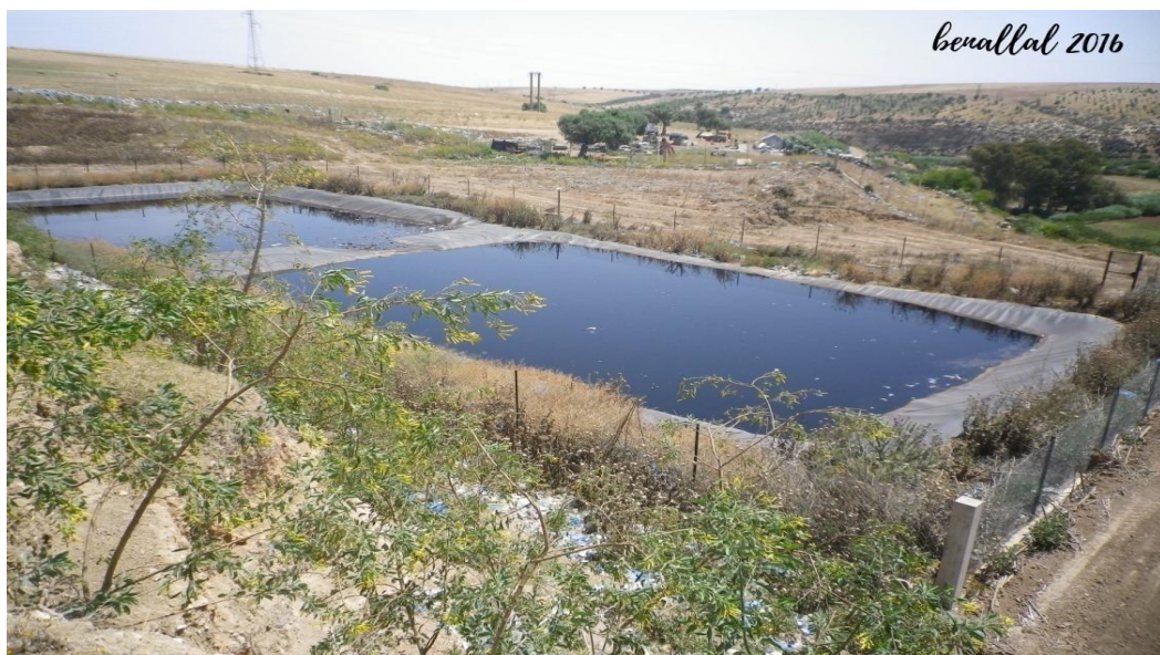
Photo n° 16 : le bassin de lixiviats de (C.E.T) de Sidi Ben Adda.
