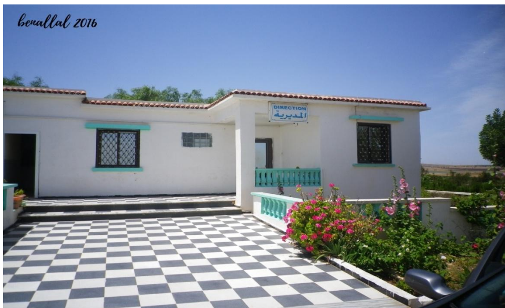
Photo n°3 : Le bloc administratif de (C.E.T) de Sidi Ben Adda.
