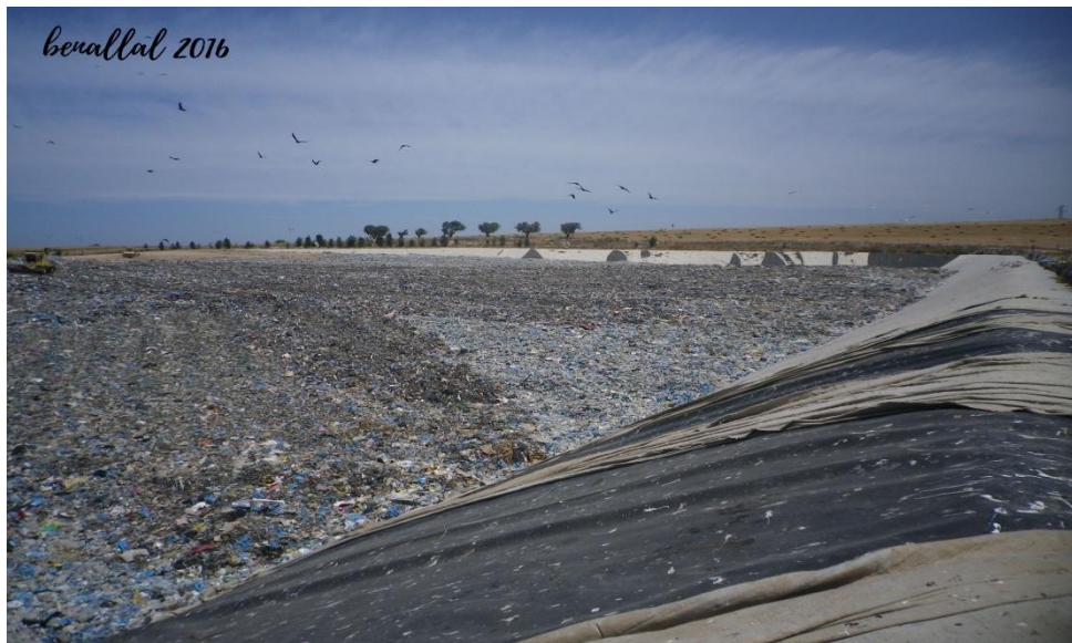
Photo n°12: Le Casier D'enfouissement de (C.E.T) de Sidi Ben Adda.
