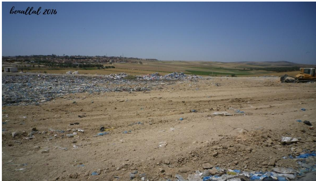
Photo n°15 : Le Casier D'enfouissement de (C.E.T) de Sidi Ben Adda.
