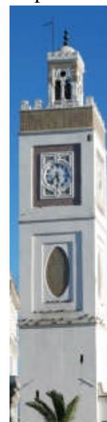
Fig.65 :le minaret de Djamaa djedid
