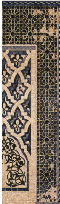
Fig.103 : minaret Sidi Abou Mediene détail lanternon
