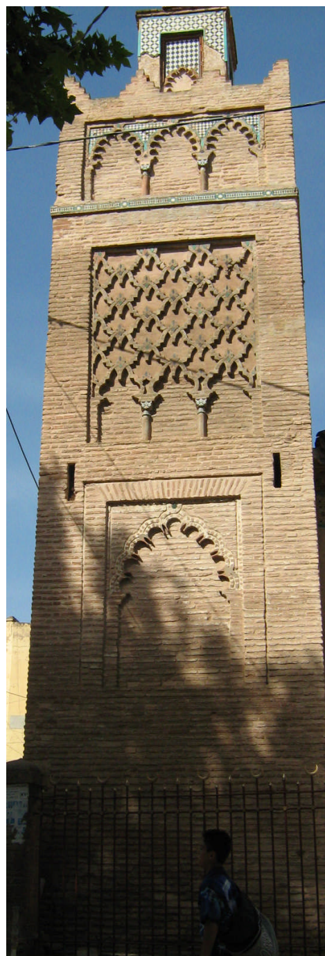
Fig.80 : le minaret de la mosquée de sidi Bel-Hassan. Façade Est
