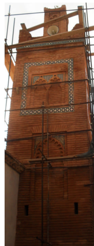
Fig.82: Minaret Mosquée d'Awlad Al-Imam. Façade Sud
