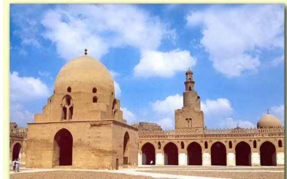
Fig. 46 : Mosquée Ibn Touloun avec la salle d'ablution à l'intérieur de la cour
