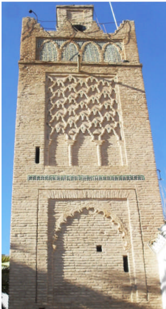
Fig.84 : minaret de la Mosquée de Sidi Brahim El Masmoudi. Façade Sud
