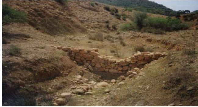
Figure 10 : Seuil en pierre sèche avec déversoir de forme curviligne (Zékri, 2000)
