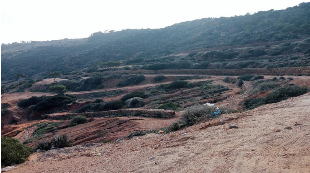
Photo 1 et 2 : station 1 de la plage de Sidi Driss protégée contre l'érosion hydrique par des gabions construits sous forme de mûrs
