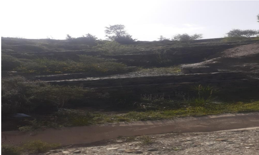
Photo 14 : seuil en gabion stable dans la station d'Ouled Ben Ayed
