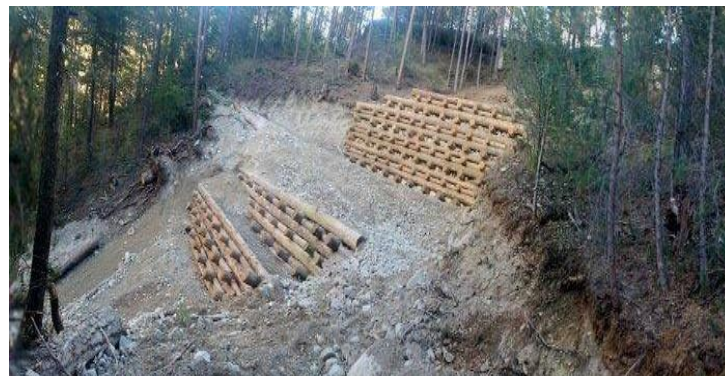
Figure 14 : Seuil en traverses de bois (Zekri, 2023)
