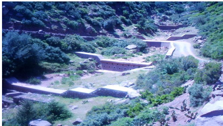
Figure 12 : Seuil en maçonnerie (Zekri, 2023)
