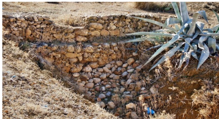
Figure 11 : Seuil en gabion avec un déversoir de forme trapézoïdale et bassin de dissipation (Zekri, 2023)
