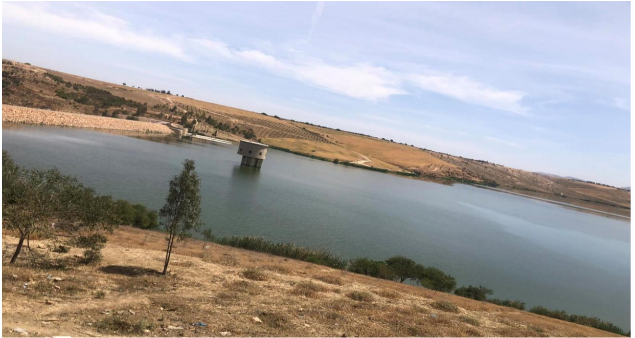
Figure 2: le barrage de Sekkak- Tlemcen.
