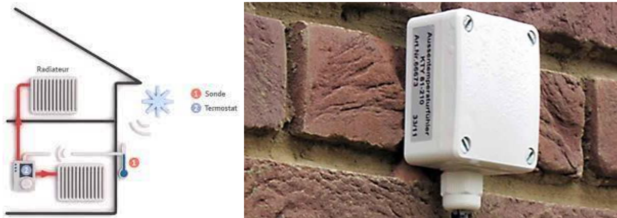
Figure 4. 36 - Sonde extérieure. [32]
