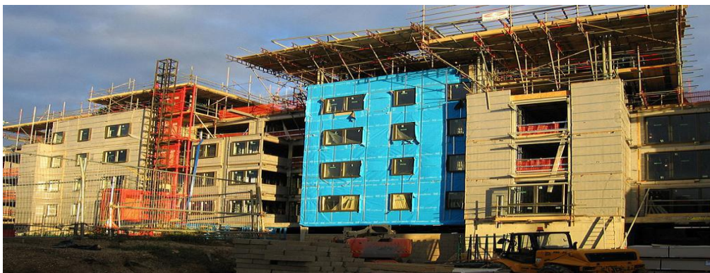
Figure 1. 8 - Les bâtiments sont isolés par l'extérieur afin de limiter les ponts thermiques. [7]
