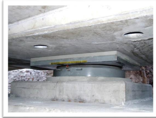
Figure 1- 10 :Appareil d'appui sous le pont de Fleurimont, France
