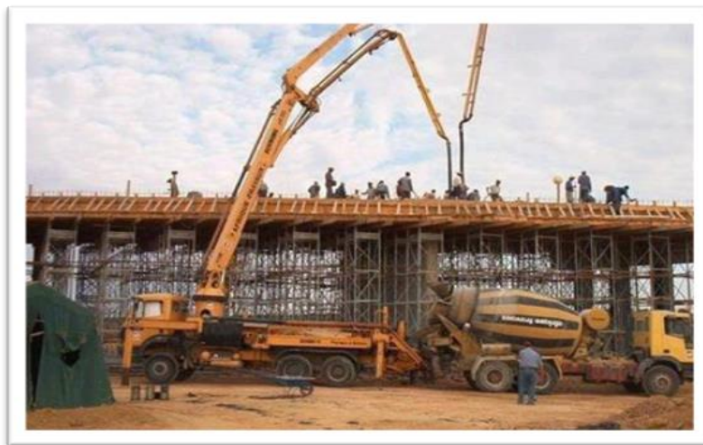
Figure 1- 17: Pont dalle coulé sur échafaudage au sol, Tunisie.
