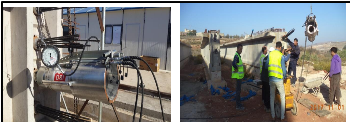
Figure 2- 16 : Vue sur la mise en tension des câbles précontraints
