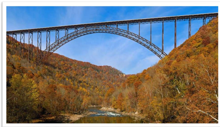
Figure 1- 11: Le new river gorge bridge, États-Unis
