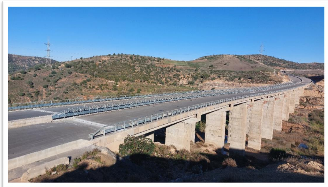
Figure 2-2 : Vue latérale du viaduc V8.7 de la pénétrante de Ghazaouet Tlemcen
