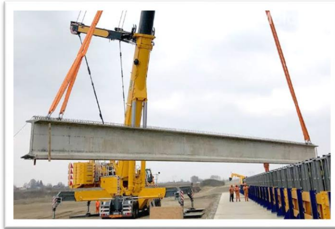
Figure 1- 18: Mise en place des poutres préfabriquées, Chine
