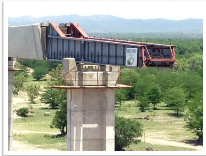
Figure 1- 20: Poussage des poutres de pont d'anisacate, Argentine
