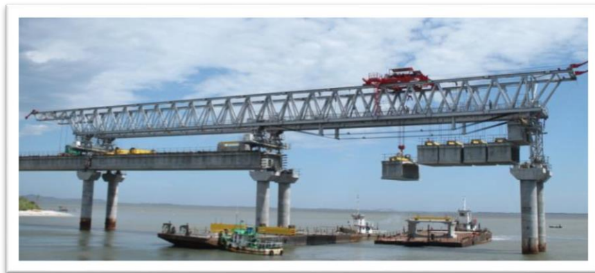
Figure 1- 19: Lancement des poutres à Santa Catarina, Brésil
