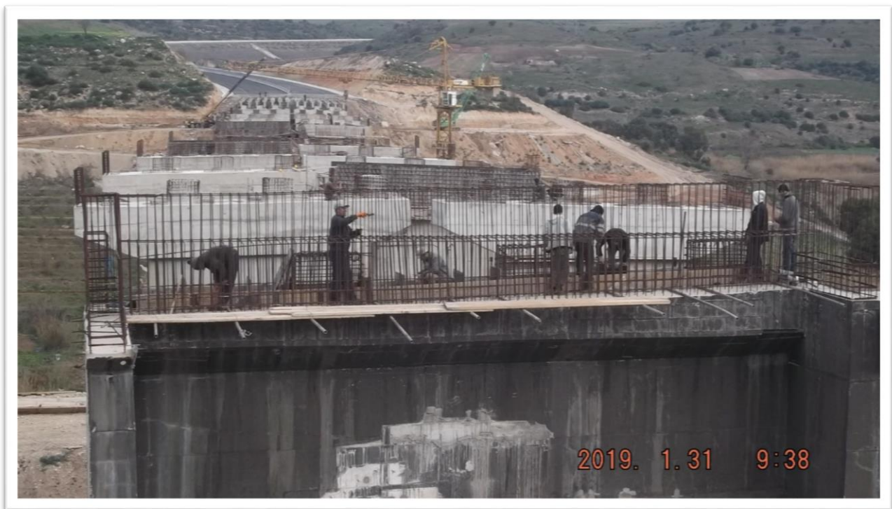
Figure 2- 14: Réalisation de la culée C 12 du viaduc V8.7
