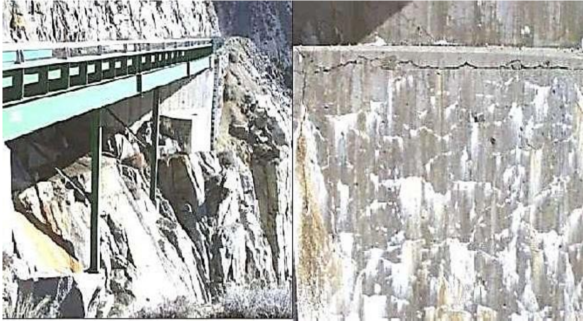
Figure 1.1 : Cas pathologiques d'éléments en béton en contact avec des sulfates. [1]
