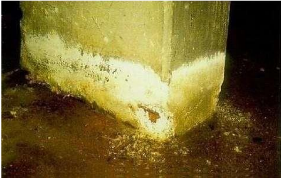
Figure 1.6 : Attaques des sulfates externes. [9]
