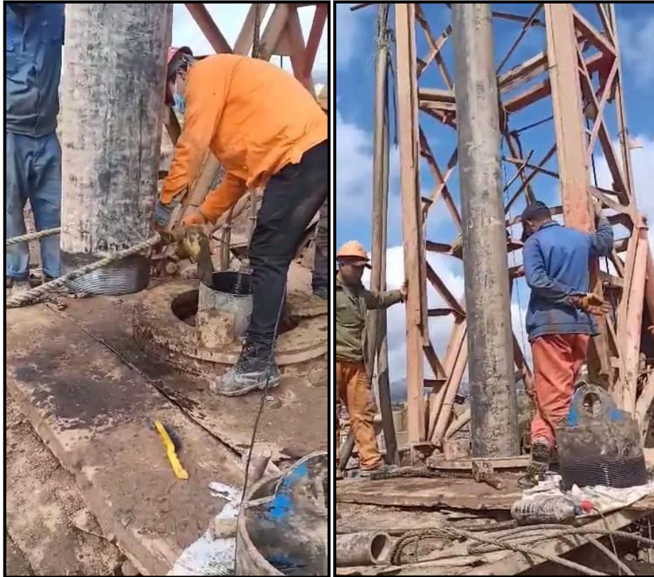
Figure 21 Phase d'équipement mise en place du tubage (tube plein) à Sidi Medjahed
