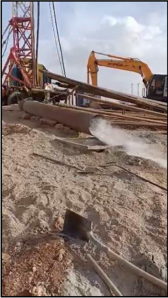
Figure 28 Photos démontrant le développement à l'air lift sur le forage de Sidi Medjahed
