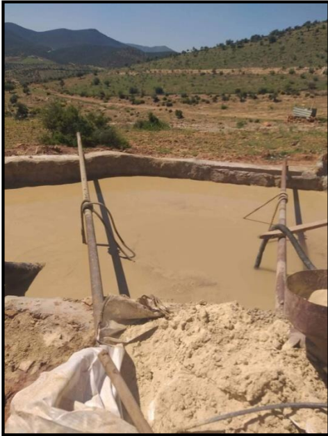
Figure 15 Le bassin de boue et les réserves de bentonites
