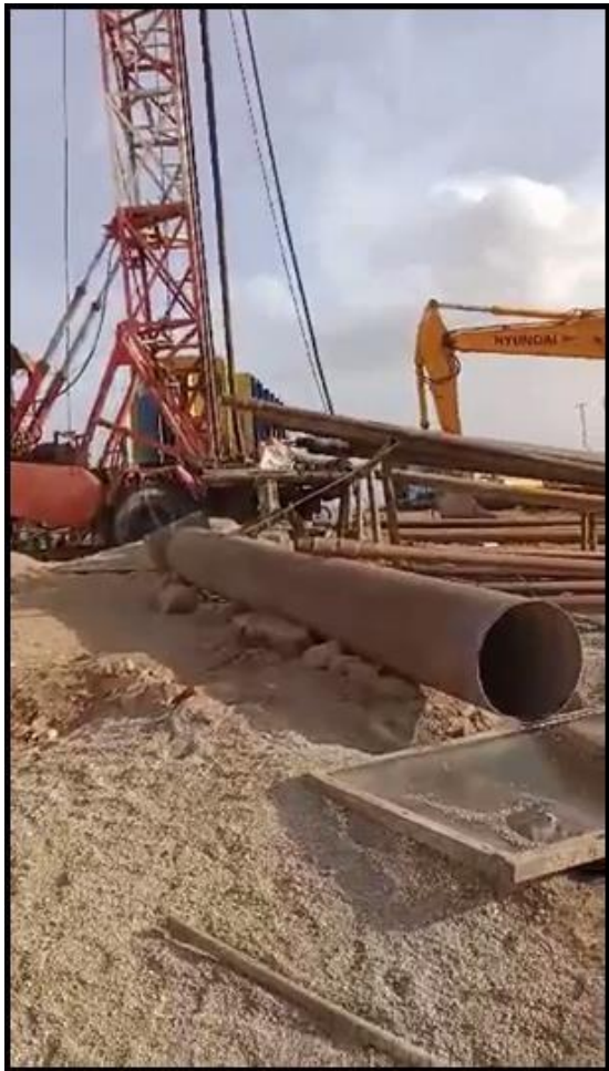
Figure 28 Photos démontrant le développement à l'air lift sur le forage de Sidi Medjahed
