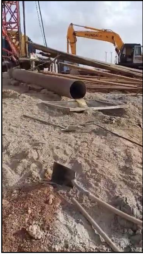
Figure 28 Photos démontrant le développement à l'air lift sur le forage de Sidi Medjahed
