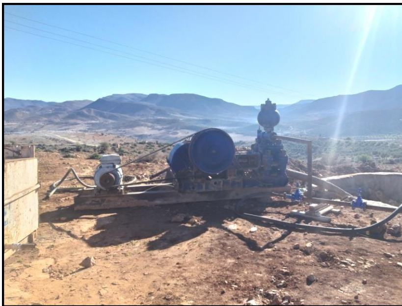
Figure 14 Pompe à boue utilisée lors du forage sur le site de Sidi Medjahed
