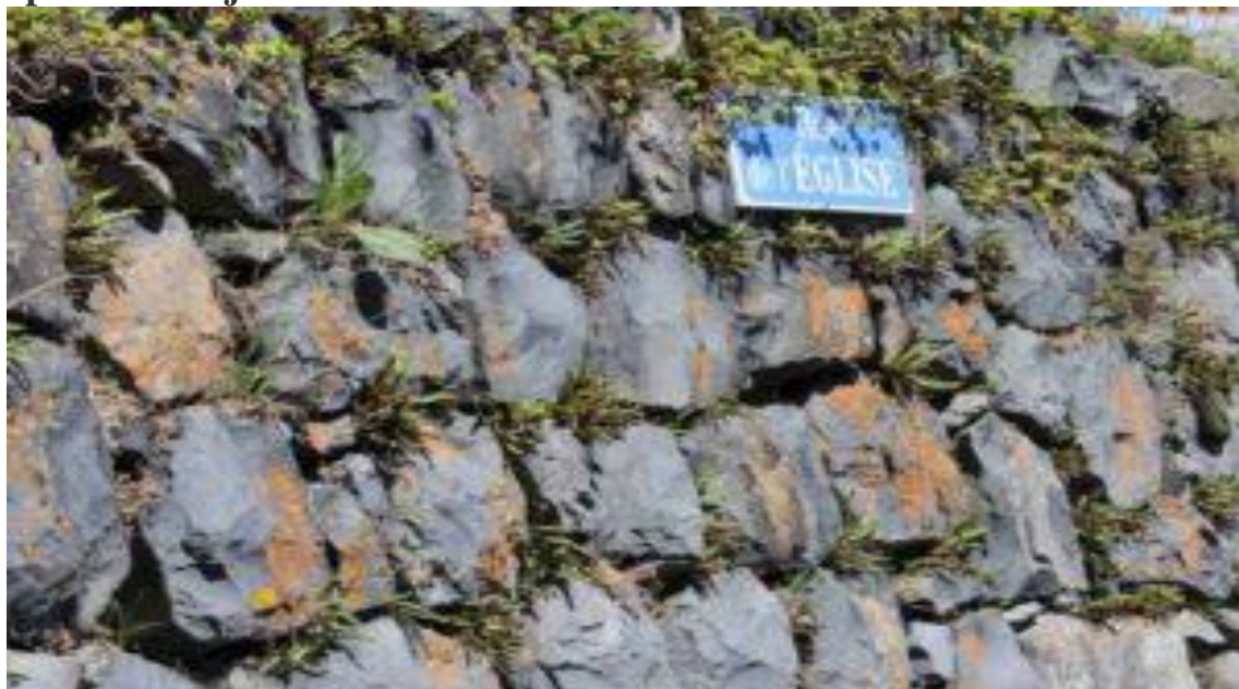
Figure 7 : Murs sans joints évidemment des repères idéaux pour la flore des murs
