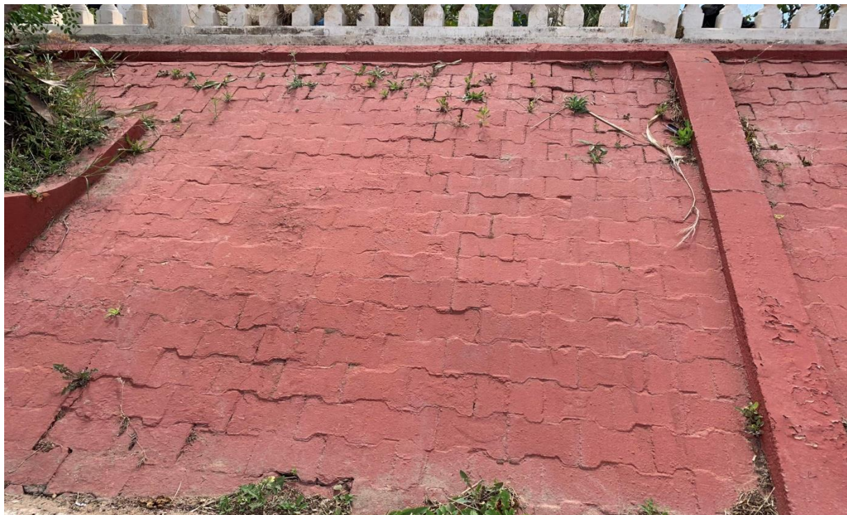
Figure 6: Un mur en brique à Tlemcen
