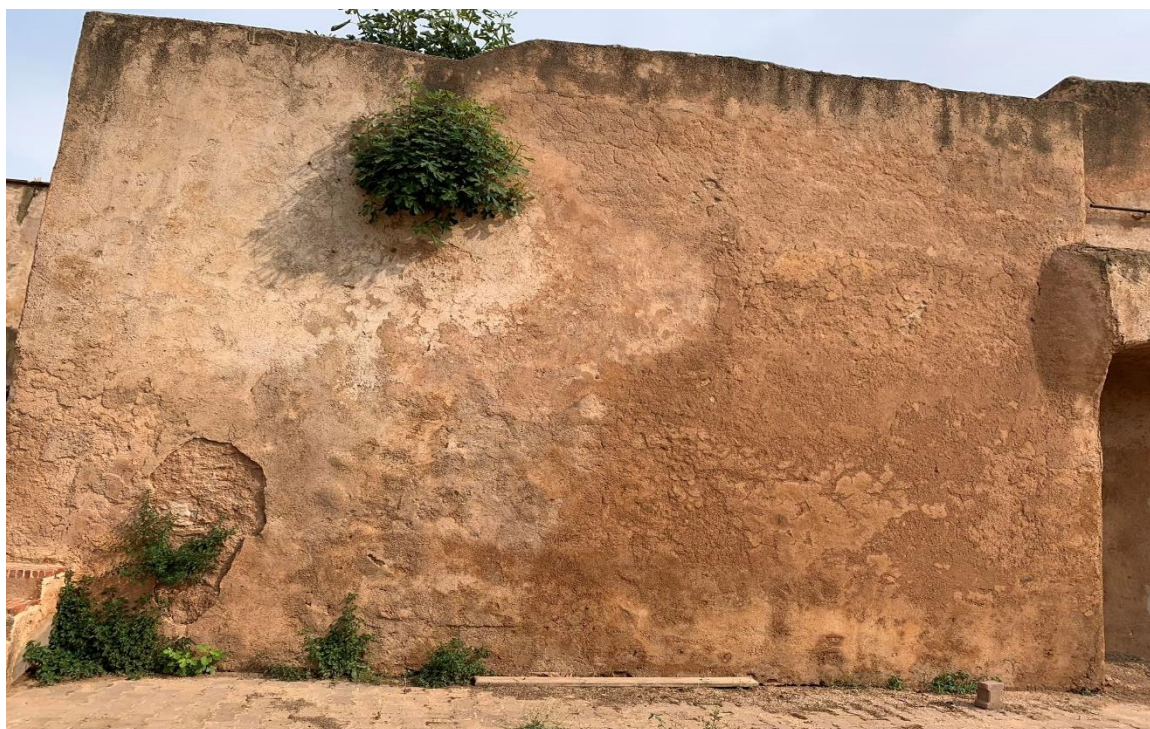
Figure 4: Un vieux mur végétalisé à Tlemcen (intérieur de Mechouar)
