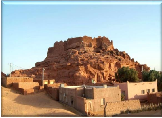
Figure 13: Photos Du Ksard'Ighzer
