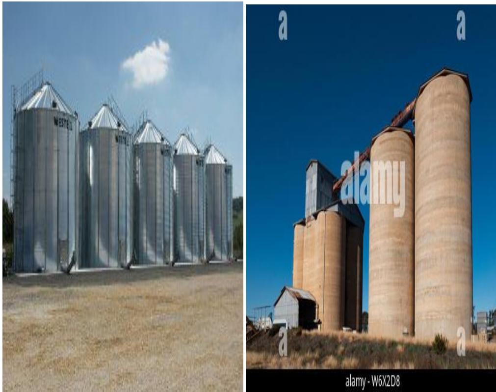
A - Silos métallique
